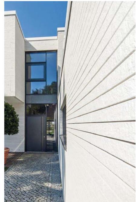
Als Verfugung wird ein Fugenglattstrich empfohlen. Dabei wird der beim Aufmauern herausquellende Mörtel nach Beginn des Ansteifens mit einem Fugholz oder Schlauchstück – ggf. über eine Fugenkelle gezogen – glattgestrichen.
