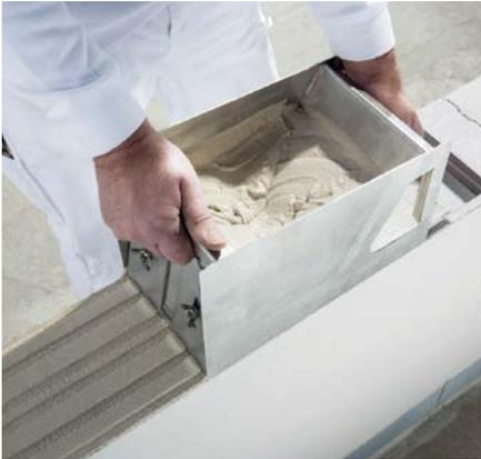
Der gleichmäßige Mörtelauftrag bei Einsatz von Mörtelschlitzen ermöglicht ein lückenloses Versetzen der Steine. Bei Steinen mit Nut-Feder-System lassen sich so ebene Wandflächen erzielen, dass der Einsatz von kostengünstigem und flächensparendem Dünnlagenputz (ca. 5 mm) möglich ist. Bei zweischaligen Haustrennwänden hat das fachgerechte Aufziehen des Dünnbettmörtels den Vorteil, dass kein Mörtel in die Luftschicht fällt und die Schalldämmung somit nicht beeinträchtigt wird.
