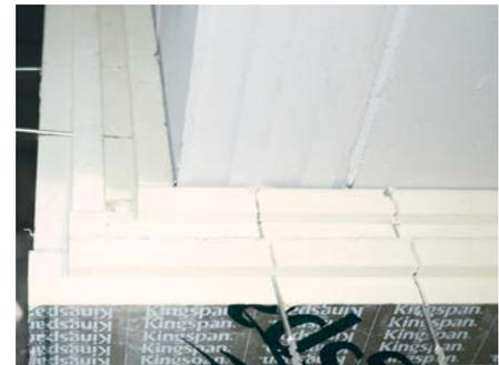
Zweischaliger Wandbau mit KS und einem PUR/PIR Dämmstoff (U-Werte s. S. 25)
