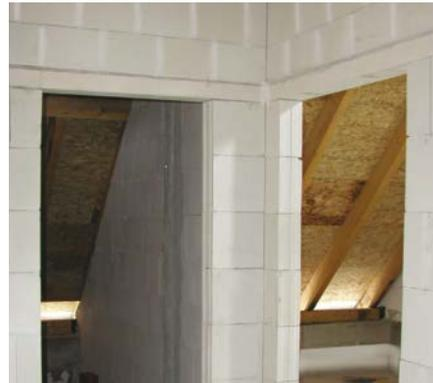
KS-Flachsturz mit vermörtelten Stoßfugen in der Übermauerung (Druckzone)
