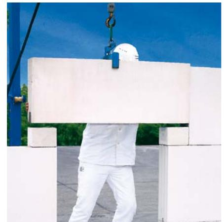
Versetzen eines KS-FTS-Fertigteilsturzes. Allgemeine bauaufsichtliche Zulassung Z-17.1-621
