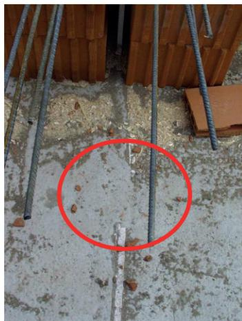
Schallbrücken durch das Gießen einer Geschossdecke
