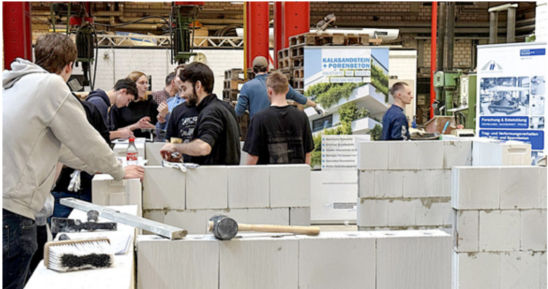
An sechs Stationen wurde ein T-Stück mit Kalksandstein- und Porenbetonsteinen im Dünnbettmörtel erstellt.
