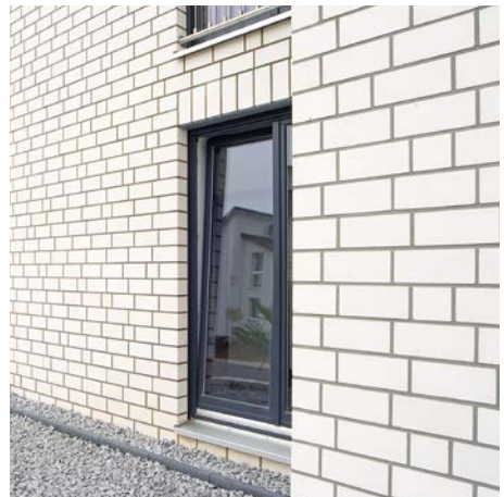
Bild 12 Sichtmauerwerk als gestalterisches Element der Fassade
