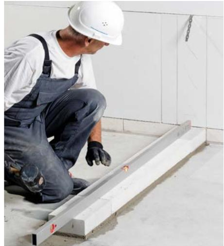
**Bild 9** Kimmsteine in Längsrichtung ausrichten
