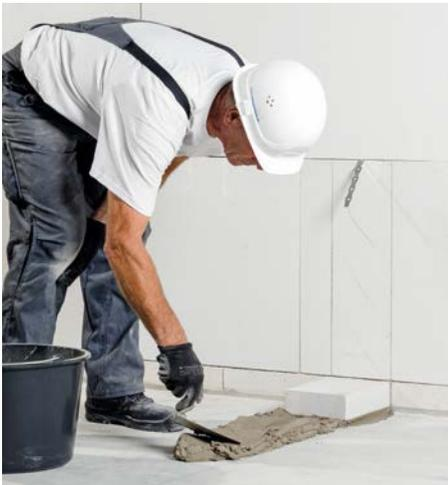
**Bild 6** Mörtel auf die Betonsohle auftragen
