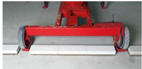
**Bild 10** In der Kimmschicht sind ggf. Lücken für das Versetzgerät frei zu lassen.
