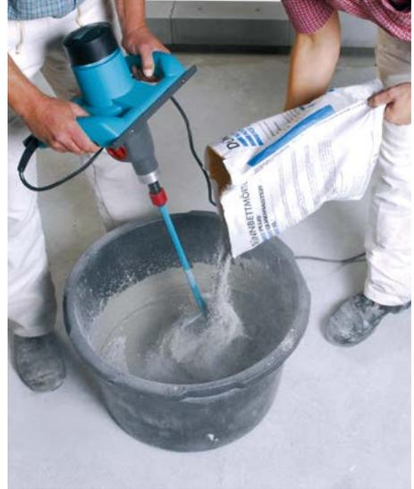
**Bild 13** Der Werkmörtel wird in den Maurerkübel eingestreut.
