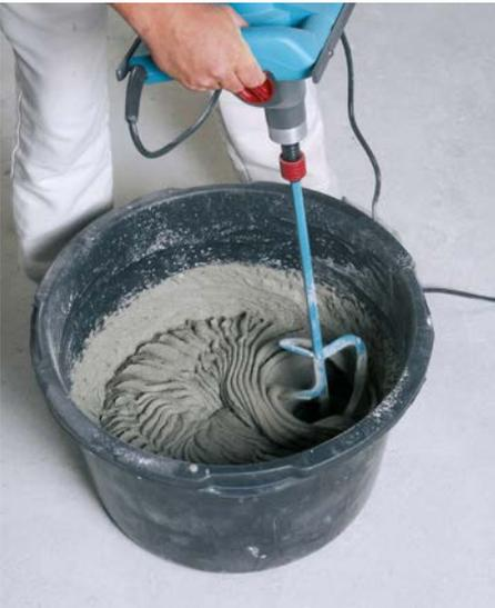
**Bild 14** Der Mörtel wird nach Verarbeitungsanweisung gleichmäßig durchgemischt.
