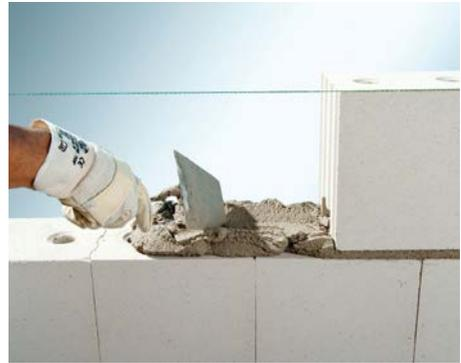
**Bild 4** Verarbeitung von Normalmauermörtel
