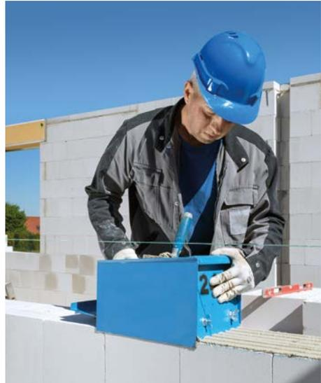
Bild 17 Der Dünnbettmörtelauftrag erfolgt einfach und schnell mit dem Mörtelschlitten.
