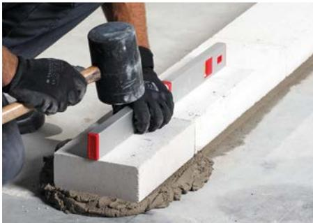
Bild 2 Kontrolle der Ebenheit in Wandlängsrichtung
