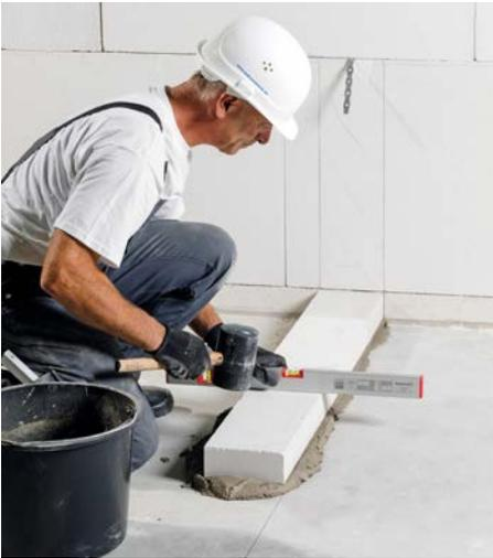
**Bild 8** Kimmsteine in Querrichtung ausrichten
