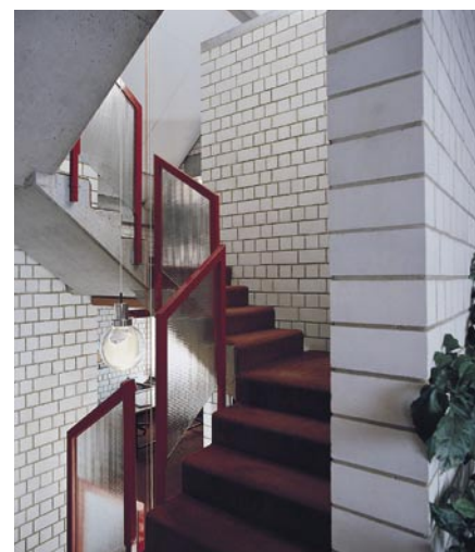
Bild 3/3: Kalksandsteinmauerwerk im Kellerbereich bietet hochwertige Gestaltungsmöglichkeiten.
