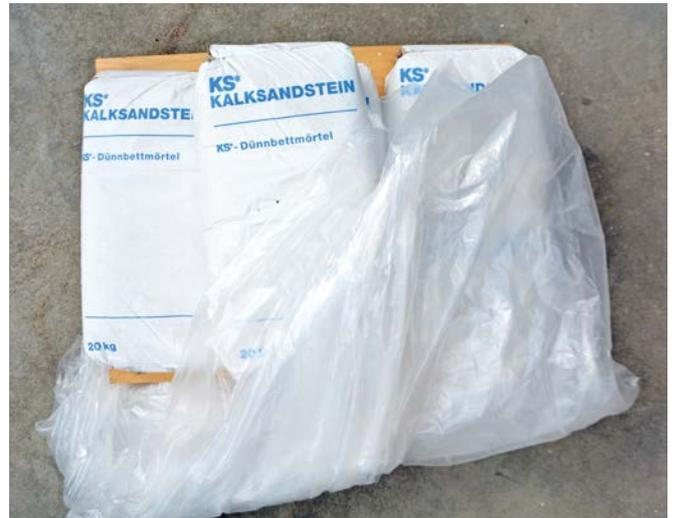
Bild 2 Der Werk-Trockenmörtel ist vor Witterungseinflüssen zu schützen.
