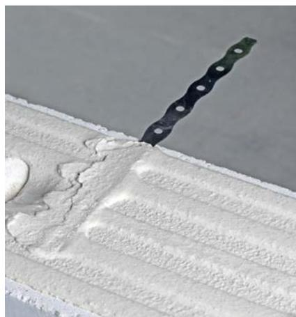
Bild 35 Stumpfstoßtechnik: Mörtelbett mit Edelstahl-Flachanker
