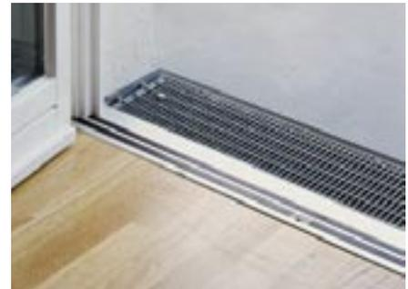
Bild 35: Schwellenfreier Übergang zum Balkon (Neubau und Altbau)
