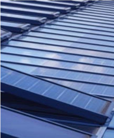
Glasdach mit integrierter PV von oben
