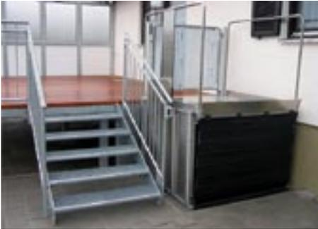
Bild 24: Hubplattform für die Überwindung kleiner Höhenunterschiede
