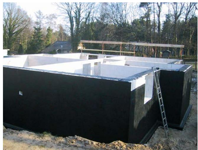
Bild 6 Kellerwand-Außenseite mit PMBC-Abdichtung
