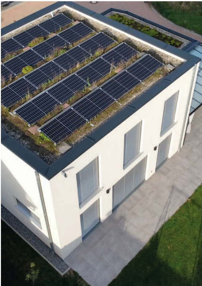
Bild 25 Dach mit Photovoltaikanlage
