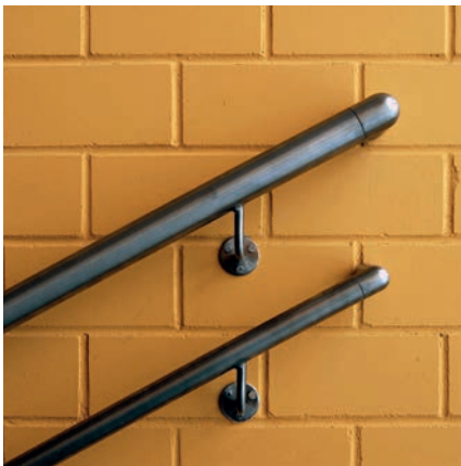
Bild 1 Befestigung von Treppengeländern an KS-Mauerwerk
