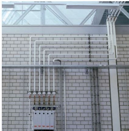
Bild 2 Innensichtmauerwerk aus Kalksandstein mit befestigten Installationsleitungen
