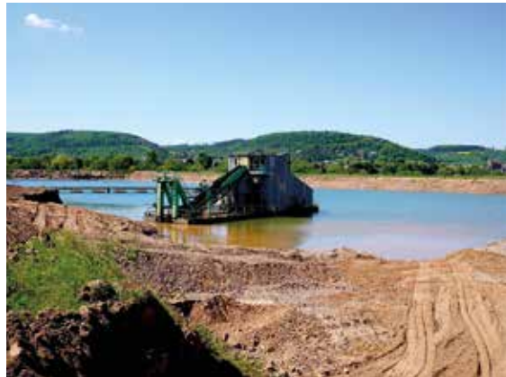
Im KW Lauenförde der H. Eggersmann GmbH & Co. KG ist ein zum besseren Lärmschutz eingehauster schwimmender Eimerkettenbagger zur Gewinnung der Kiessande der Weser-Niederterrasse in Betrieb, Foto: BGR.
