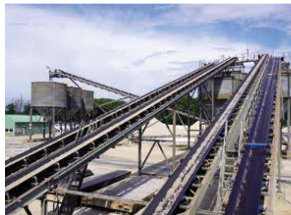
Im KW Walchum der Heeren-Herkener Kiesbaggerei GmbH werden vier verschiedene Sandfraktionen produziert und diese dann zu unterschiedlichen Sandsorten verschnitten, Foto: BGR.
