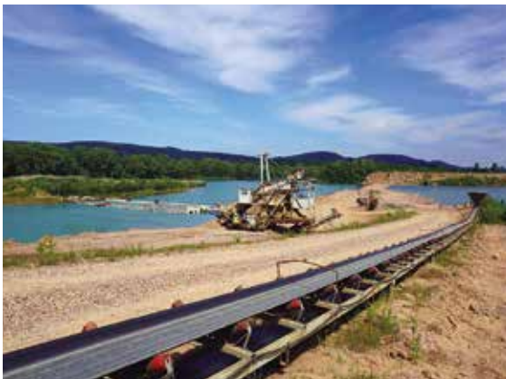
In der Kiesgrube Bokshorn wird der tiefere Teil der Kiessandabfolge im Nassen durch einen Schrapper mit Ausleger ausgekiest, Foto: BGR.
