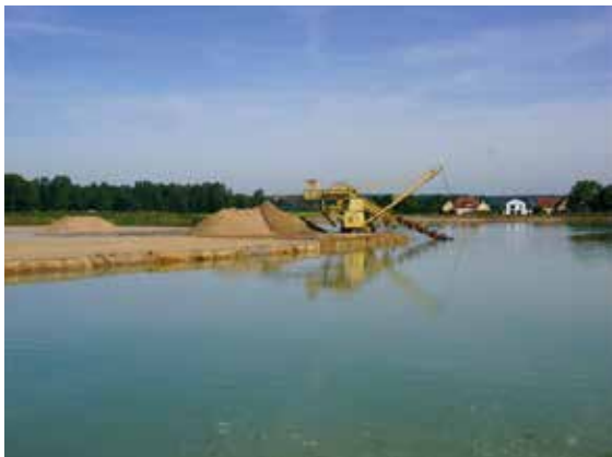
Im Kiesabbaugebiet Hörblach erfolgt die Gewinnung der Kiessande durch die LZR Lenz-Ziegler-Reifenscheid GmbH mit einem landgestützten Eimerkettenbagger, Foto: BGR.
