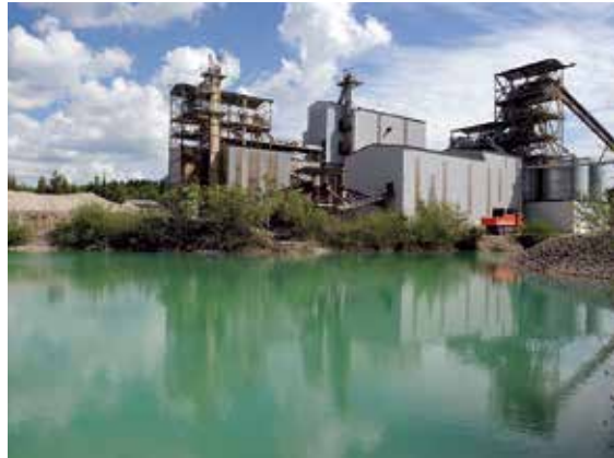
Im KW Unlingen werden seit über 60 Jahren hochwertige rißeiszeitliche Kiessande gewonnen und aufbereitet, Foto: Wenzelburger Kieswerke GmbH & Co. KG (mit frdl. Genehmigung).
