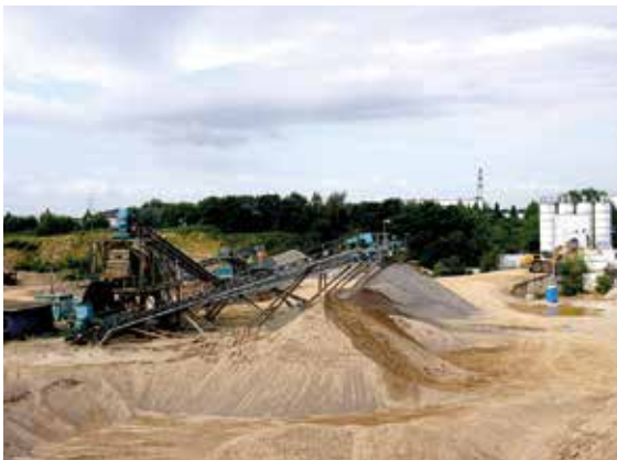
Fast die gesamte Produktionsmenge des KW Niederkassel dient zur Versorgung eines auf dem Werksgelände produzierenden Transportbetonwerks, Foto: BGR.
