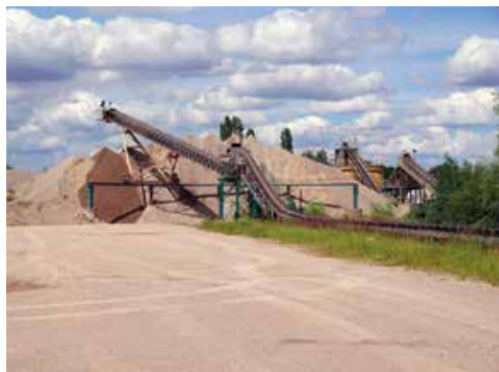
Der mittels eines Schöpfkrads vorgetrocknete Kiessand wird über ein Förderband zur Rohkiessandhalde des KW Leubingen transportiert, Foto: BGR.
