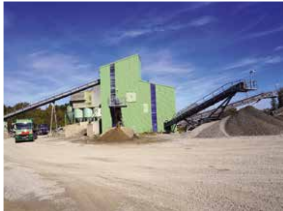
Das KW Herzmanns/Eggen der Geiger Unternehmensgruppe nimmt wichtige Aufgaben in der Versorgung gruppeneigener Transportbeton- und Asphaltmischwerke wahr, Foto: BGR.
