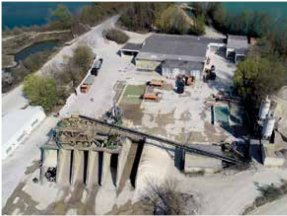
Luftaufnahme des KW Ingolstadt-Irgertsheim, wo neben Gesteinskörnungen zugleich auch Transportbeton produziert wird, Foto: Franz Schimmer GmbH (mit frdl. Genehmigung).
