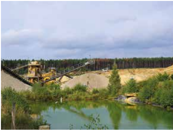
Das KW Strauch der SKR Sand-Kies-Recycling GmbH bei Großenhain bereitet Schmelzwasserkies-sande der Saale-Eiszeit zu hochwertigen Gesteinskörnungen auf, Foto: BGR.
