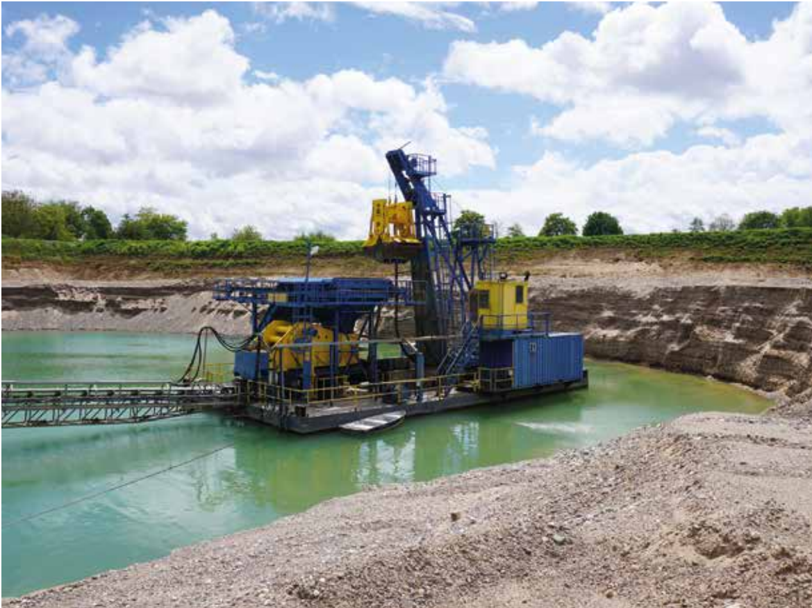
Im linksrheinischen Urmitz gewinnen die KANN GmbH Baustoffwerke seit 30 Jahren hochwertigen Kiessand aus der Niederterrasse des Rheins, von dem rund die Hälfte oberhalb des Grundwasserspiegels ansteht, Foto: BGR.
