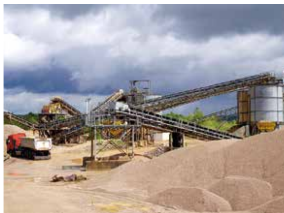
Das Kieswerk Besch-Nennig (KBN) versorgt zu einem Großteil Kunden im nahen Luxemburg mit hochwertigen Sanden und Kiesen zur Produktion von Transportbeton und Betonfertigteilen, Foto: BGR.
