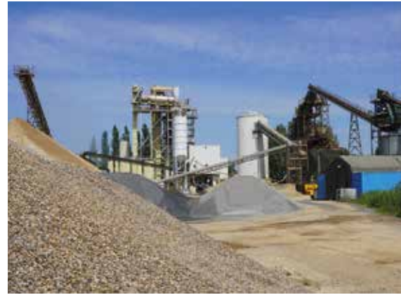
Das KW Grafenrheinfeld der Bauunternehmung Glöckle Baustoffwerke GmbH trägt erheblich zur Baustoffversorgung im Landkreis Schweinfurt bei, Foto: BGR.
