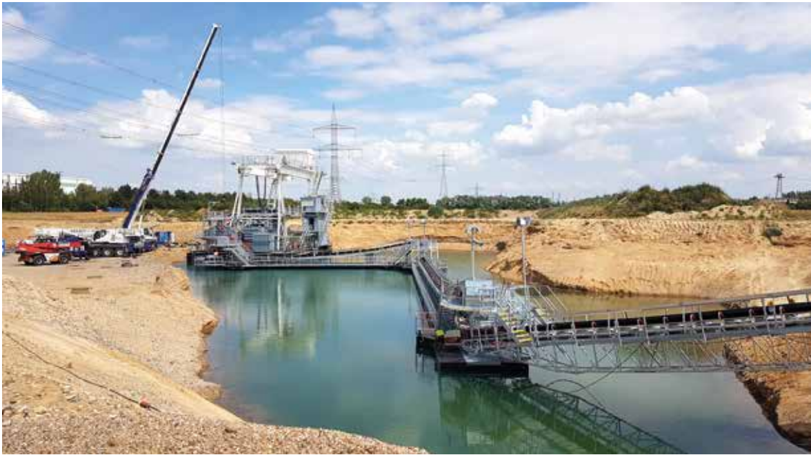
Montage des neuen, rund 4,0 Mio. € teuren Schwimmgreifers im Abbaufeld Röderau des Holcim Kieswerk Zeithain im Jahr 2020, Foto: Holcim Kieswerk Zeithain KG (mit frdl. Genehmigung).
