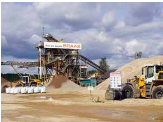
Obwohl vor Ort schon lange keine Dachsteine produziert werden, gibt die Aufbereitungsanlage im KW Hoppegarten seine Vergangenheit noch klar zu erkennen, Foto: BGR.
