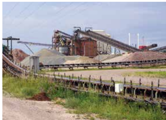
Im KW Erfurt-Nord der K+B Kies und Beton GmbH werden vornehmlich Gesteinskörnungen für die unternehmenseigenen Transportbetonwerke produziert, Foto: BGR.
