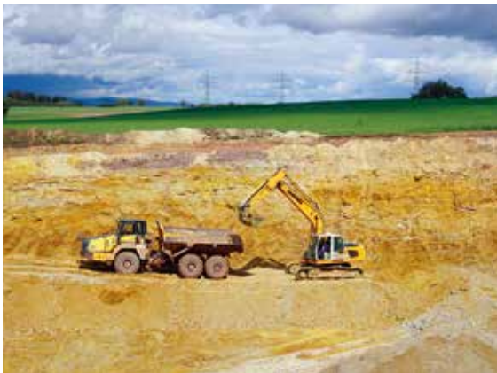
Gewinnung von Kiessand durch Hydraulikbagger in der erst vor drei Jahren neu eröffneten Grube der Mick Kies GmbH bei Dodenburg, Foto: BGR.
