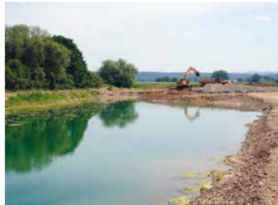
Anlage eines weiteren Flussmäanderbogens zugunsten der Natur und des Hochwasserschutzes und zugleich Gewinnung von hochwertigem Kiessand durch die Firma Porzner Steine & Erden GmbH am Main nördlich Zapfendorf, Foto: BGR.
