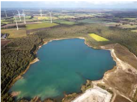
Luftaufnahme des Baggersees des KS-Werks Bösel mit einem Teil des Spülfeldes im Vordergrund rechts, Foto: Gräper-Unternehmensgruppe (mit fdl. Genehmigung).
