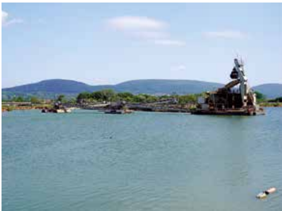
Im Baggersee des Kieswerks H. Pampel werden mit einem Schwimmgreifer die hier bis zu 18 m mächtigen Kiessande der Weser gefördert, Foto: BGR.
