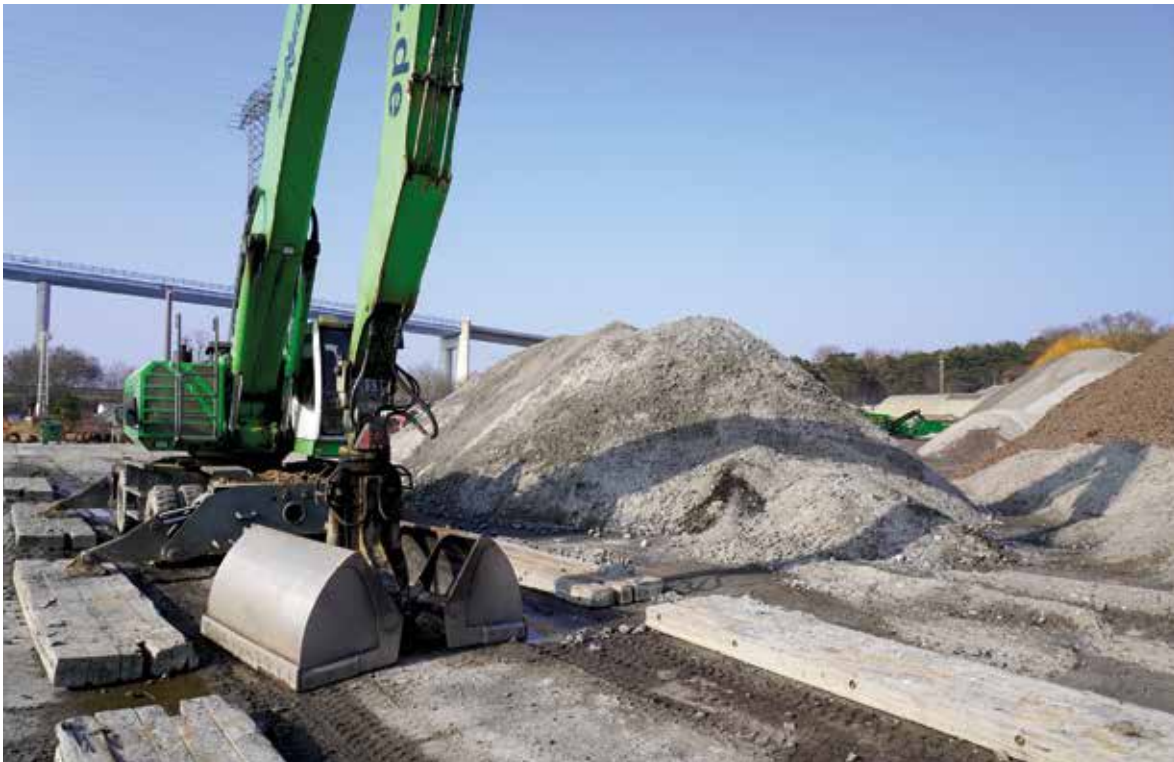
Im Hafen von Stralsund, genauer auf dem dortigen Firmengelände der André Voß Erdbau und Transport GmbH auf der Insel Dänholm zwischen Stralsund und Rügen, erfolgt die Entladung des im Tromper Wiek gewonnen Seekiessandes mit Hilfe eines Baggers, Foto: BGR.
