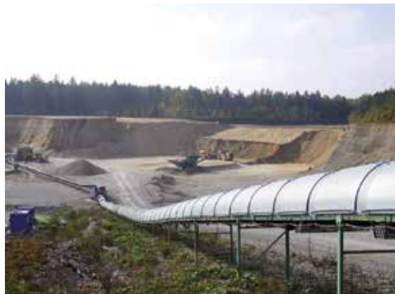
Das KW Gräfelfing der Bernhard Glück Kies-Sand-Hartsteinsplitt GmbH wird seit über 50 Jahren aus einem Abbaugelände in Planegg mit Rohmaterial versorgt. Der Transport erfolgt über ein 2,5 km langes, größtenteils in einem unterirdischen Tunnel verlegtes Förderband, Foto: BGR.
