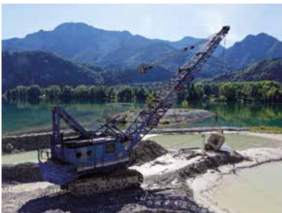
Zur Gewinnung des Geschiebes aus der Mündung der Loisach in den Kochelsee setzt die Rohrdorfer Gruppe einen Schleppschaufelbagger ein, Foto: Rohrdorfer Gruppe (mit frdl. Genehmigung).
