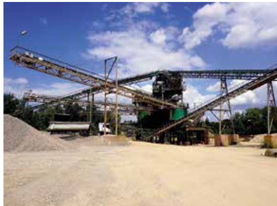
Das KW Köln-Immendorf der J & E Horst GmbH & Co. KG ist eines von nur zwei Kieswerken auf Kölner Stadtgebiet, Foto: BGR.
