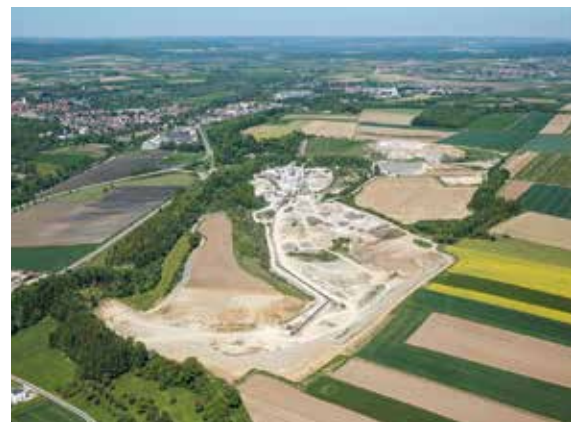
Luftaufnahme des KW Riedlingen-Neufra mit Gewinnungsareal im Vordergrund, Aufbereitungsanlage im Hintergrund Mitte und Deponie im Hintergrund rechts, Foto: Martin Baur GmbH (mit fdl. Genehmigung).
