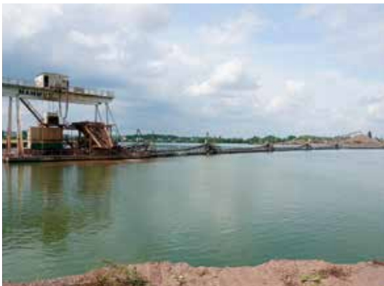
Das riesige Abbaugelände der KW Nordhausen wird durch Baggerseen dominiert; die Gewinnung der bis zu 40 m mächtigen Kiessande erfolgt mittels Schwimmgreifer, Foto: BGR.
