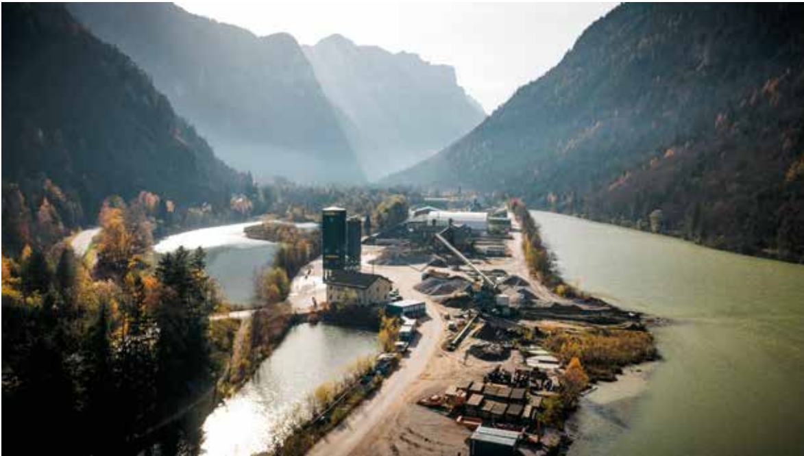
Das KW Saalachkies liegt idyllisch am gleichnamigen Stausee und wird aus dem Stausee durch einen Schrapper sowie durch Hangschuttmateriale nachhaltig mit Rohstoffen versorgt, Foto: Antretter GmbH & Co. KG (mit frdl. Genehmigung).
