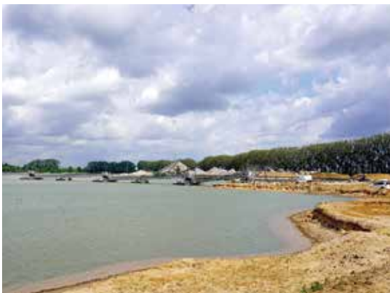
Das KW Krähenwinkel der GP Günter Papenburg AG ist das wichtigste Kieswerk in der Region Hannover, was die Versorgung des nördlichen und östlichen Stadtgebiets von Hannover mit hochwertigen Gesteinskörnungen für die Betonindustrie betrifft, Foto: BGR.
