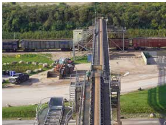
Praktisch sämtliche 800.000 t der jährlich im KW Schwarz produzierten Sande, Kiese und Splitte werden per Zug abtransportiert, Foto: BGR.
