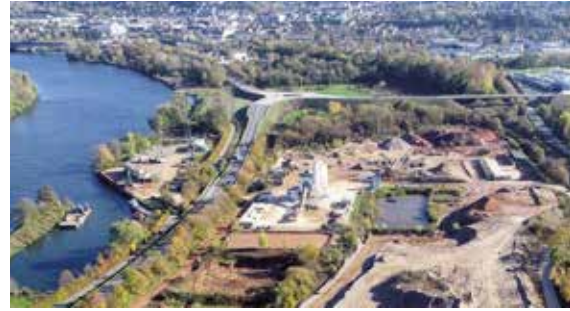
Blick über das KW Wasserliesch mit Hafen direkt an der Mosel, Foto: Joh. Wacht GmbH & Co. KG (mit frdl. Genehmigung).
