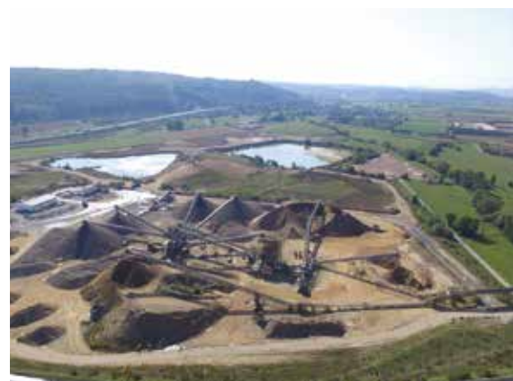
Blick über das KW Niederweimar, direkt an der B255 bzw. der B3, der Holcim Kies und Splitt GmbH, Foto: © RP-Gießen.
