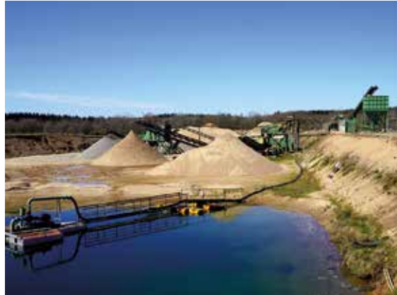
Das KW Blunk der Eggers-Gruppe dient vornehmlich der Versorgung der unternehmenseigenen Tiefbausparte mit Baustoffen, Foto: BGR.
