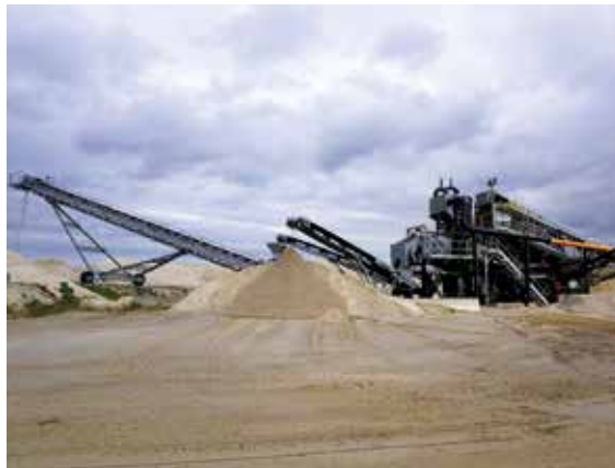
Im KW Benndorf der D-B-F Baustoff GmbH ist, eher ungewöhnlich in Deutschland, eine semimobile Aufbereitungsanlage im Einsatz, Foto: BGR.
