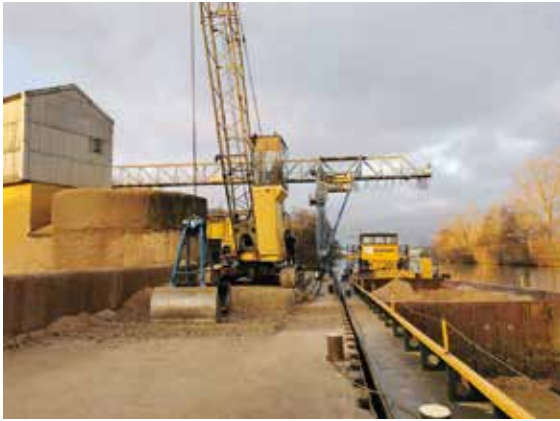
Die Veit Dennert KG verfügt bei Viereth-Trunstadt über einen eigenen Hafen zum Umschlag des auf der gegenüberliegenden Mainseite gewonnenen Kiessandes, Foto: Veit Dennert KG (mit frdl. Genehmigung).
