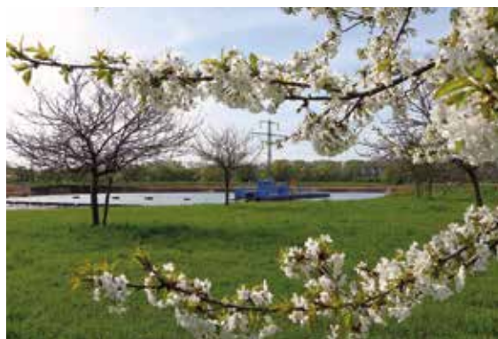
Auch im Neusee Erlache erfolgt die Kiessandgewinnung mittels Saugbagger im nachgewiesenen vollständigen Einvernehmen mit Natur und Umwelt, Foto: Wolfgang Rohr GmbH & Co. KG (mit frdl. Genehmigung).
