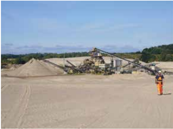
Das KW Althüttendorf ist gekennzeichnet durch große Sandhalden und weite Sandflächen, vor allem auch im Bereich des Spülfeldes, Foto: BGR.
