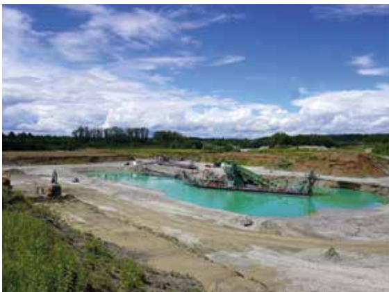
Im Tettnanger Wald ging im Mai 2021 einer der derzeit größten und modernsten schwimmenden Eimerkettenbagger Deutschlands in Betrieb, Foto: BGR.
