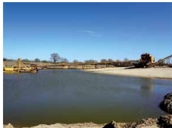
In der Gewinnungsstelle Klein Rheide – Tillhorn der Firma Jans-Naturkies wird der Rohkiessand mittels Saugbagger gewonnen, die Kiesfraktion abgetrennt und der Sand gleich danach wieder verspült, Foto: BGR.
