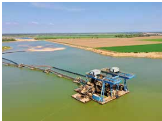
In Mühlberg/Elbe erfolgt die Gewinnung aus einer der größten Kiessandlagerstätten Europas durch zwei Doppelschwimmgreifer, Foto: Elbekies GmbH (mit frdl. Genehmigung).
