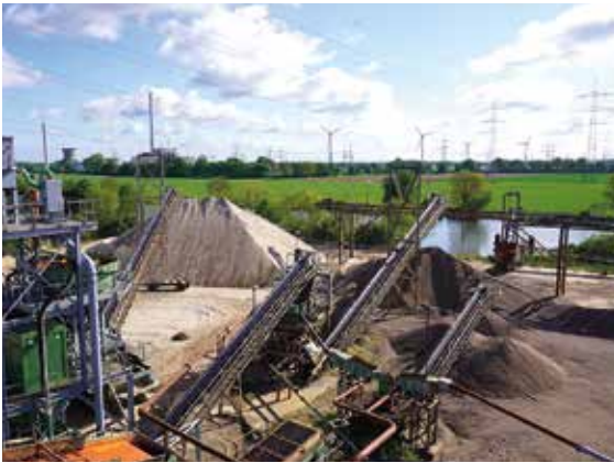
Rund 80 % der jährlichen Produktionsmenge aus der komplexen Aufbereitungsanlage des KW Schinna verlassen den Standort per Binnenschiff, Foto: BGR.
