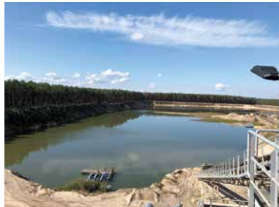
Blick von der Aufbereitungsanlage über den Baggersee des KW Linthe, Foto: Firmengruppe Max Bögl (mit frdl. Genehmigung).
