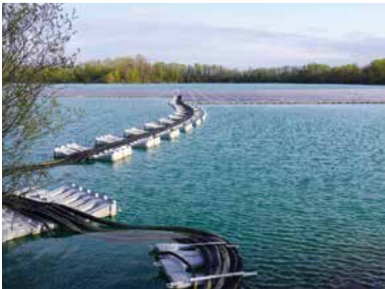
Auf einem Teil des Baggersees der Ossola GmbH in Achern-Maiwald erzeugt seit dem Jahr 2019 eine 750 kWp-Photovoltaikanlage Solarstrom für das angrenzende Kieswerk, Foto: BGR.
