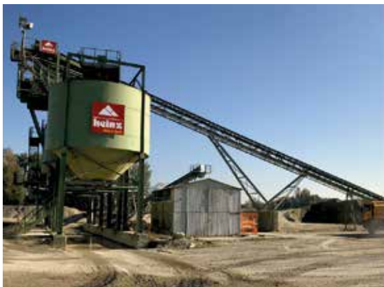
Das Unternehmen Heinz ist ein wichtiger Produzent von Baustoffen im Landkreis Eichstätt und versorgt das gruppeneigene Transportbetonwerk mit Sand und Kies aus eigener Gewinnungsstelle, Foto: Heinz Kies und Sand GmbH & Co. KG (mit frdl. Genehmigung).
