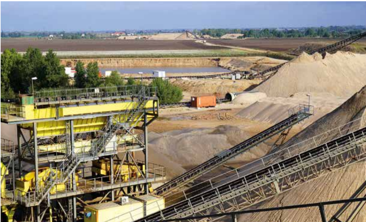
Blick von der Aufbereitungsanlage des KW Schwarz auf die Sandklassierung, den zugehörigen Baggersee und das KW Trabititz im Hintergrund, Foto: BGR.
