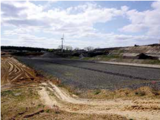
Auf ihrem Firmengelände in Harrislee betreibt die Balzersen GmbH & Co. KG im Vorfeld und zur Aufnahme der ständig wachsenden, mehrschichtigen Deponie der Klasse 1 (rechts) auch eine Sandgrube (links), Foto: BGR.
