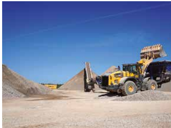
Das in großen Mengen im KW Leinetal anfallende Überkorn 32/200 mm sowie ein Teil des Grobkieses 16/32 mm werden mit einem mobilen Brecher zu einem Korngemisch 0/22 mm heruntergebrochen, das dann erneut der Aufbereitung zugeführt wird, Foto: BGR.
