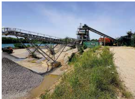
Das KW Kamp-Lintfort der FRIKA-KIES GmbH & Co. KG produziert Gesteinskörnungen ausschließlich für den regionalen Markt, Foto: BGR.
