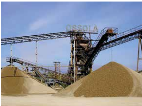
Im Kieswerk Ossola werden elf verschiedene Sorten an Sanden, Kiesen und Splitten produziert, Foto: BGR.
