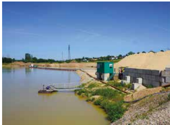
In der Gewinnungsstelle Kitzingen-Hohenfeld werden die hier bis zu 25 m mächtigen Kiessande des Mains mittels Saugbagger abgebaut und der Sand 0/2 mm gleich vor Ort abgetrennt, Foto: BGR.
