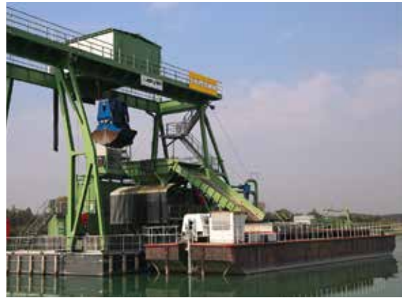
Auch im KW Rastatt-Wintersdorf ist zur Kiessandgewinnung aus bis zu 44 m Tiefe ein großer Schwimmgreifer im Einsatz. Die auf einem Gitterrost abgetrennten Steine, Tonklumpen und Holzreste gelangen über eine Schurre in eine Schute, die sie in Flachwasserzonen zur Rekultivierung wieder verklappt. Der nutzbare Kiessand wird dagegen über ein Förderband in die Aufbereitungsanlage transportiert, Foto: Sämann Stein- und Kieswerke GmbH & Co. KG (mit frdl. Genehmigung).
