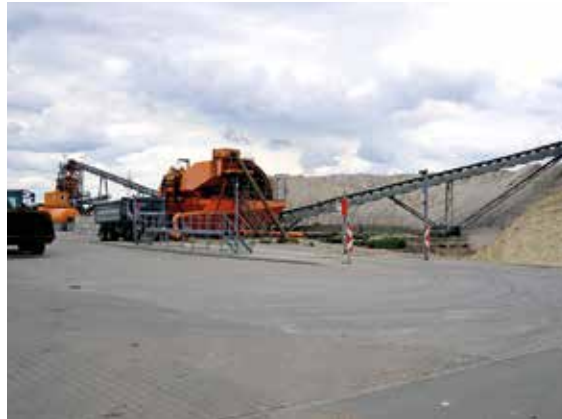
Im Sandwerk Berne-Harmenhausen werden hochqualitative, kohlefreie und quarzreiche Grobsande produziert, die sich hervorragend als Grundlage zur Anmischung von Estrichsand 0/8 mm eignen würden, Foto: BGR.
