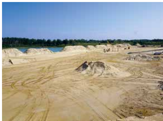
Keinen Kies oder Kiessand, sondern nur Sand für die eigene Baustoffproduktion gewinnen die Baustoffwerke Havelland GmbH & Co. KG in ihrem Sandtagebau Germendorf, Foto: BGR.
