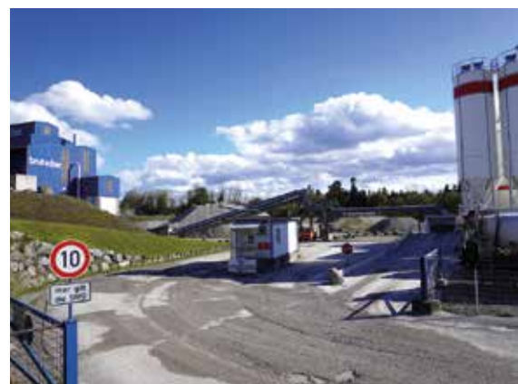
Das KW Hafenthal der Brutscher GmbH & Co. KG (blau im Hintergrund) versorgt mit einem Großteil seiner Rundkörnung direkt das benachbarte Transportbetonwerk der SCHWENK Beton Allgäu GmbH & Co. KG (weiß im Vordergrund), Foto: BGR.
